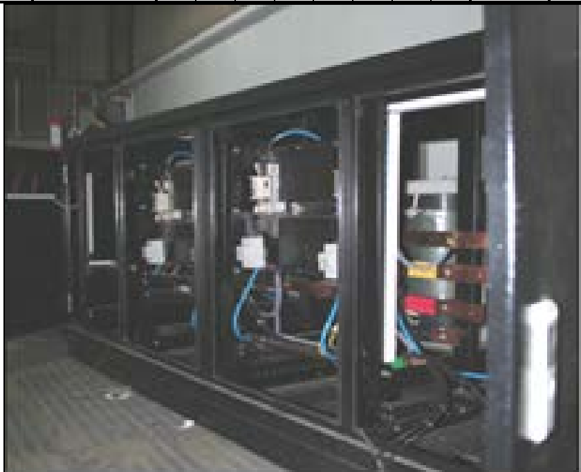
شکل ۵-۱۹- نمونه فیلتر طراحی و ساخته شده برای مقابله با امواج الکترومغناطیسی
